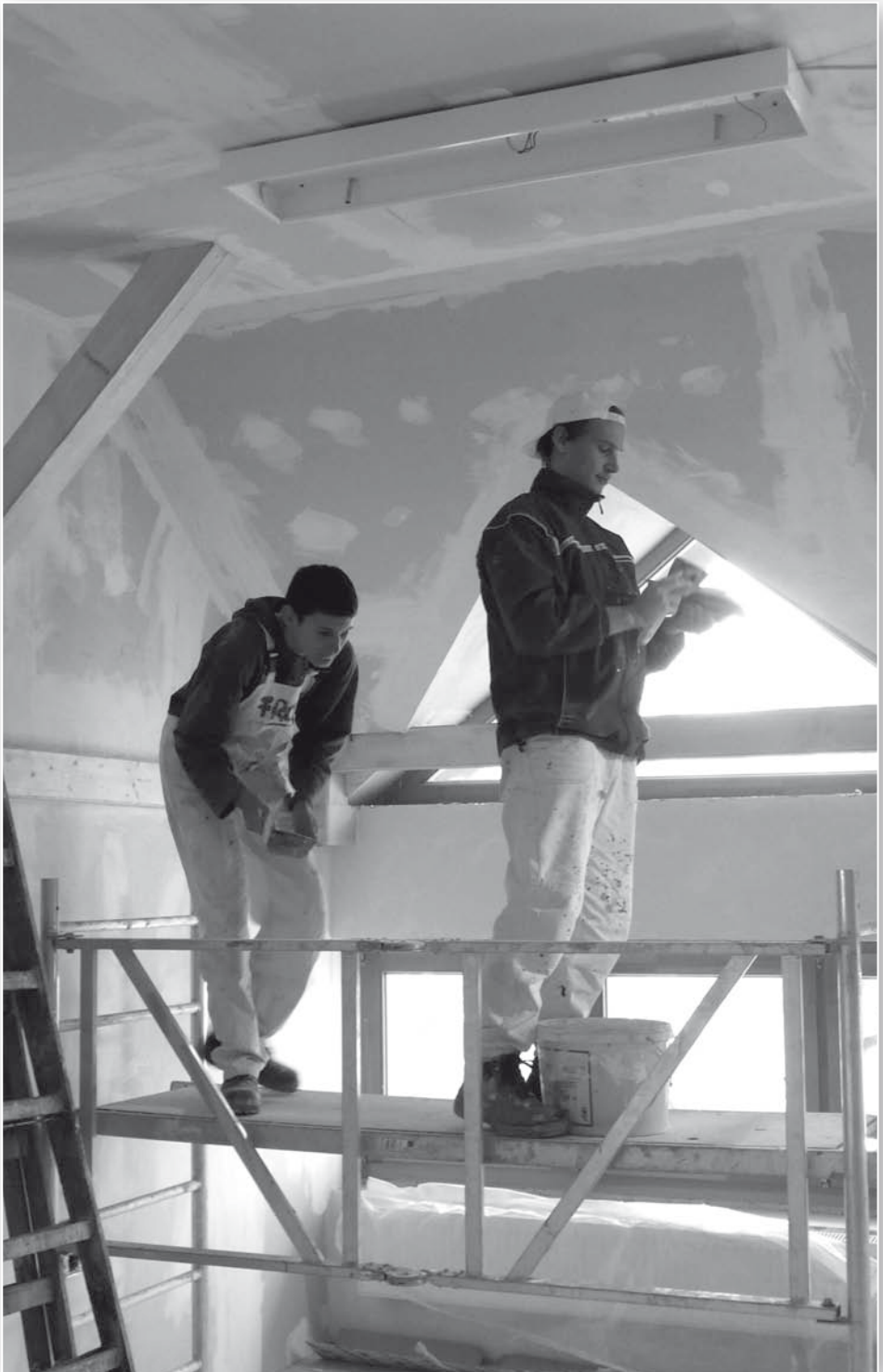
Wind Tamás és András Richárd festőtanulók a modellterem falfelületének glettelését végzik (2009)
