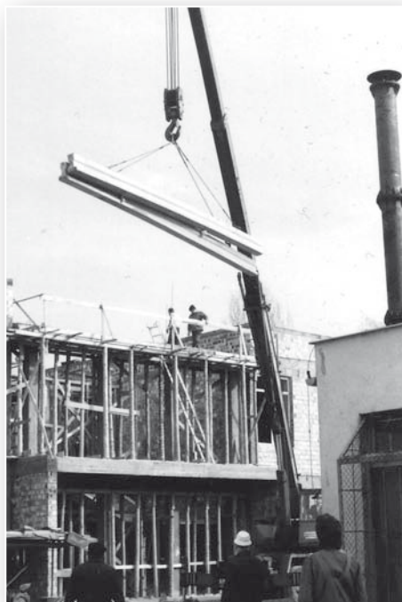
Födémgerendát emel be a daru az iskola új szárnyának építéskor (1991)
