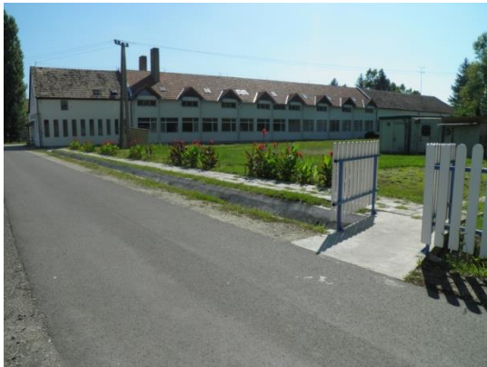
Az aszfaltút a vízelvezetéssel
